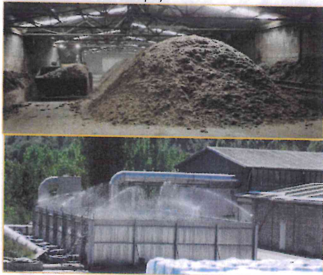
Figura 1: Impianto di compostaggio interno e biofiltro esterno.
